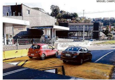
UN RESALTO ESTÁ A METROS DE LA CURVA QUE CONECTA CON AV. ARGENTINA.
